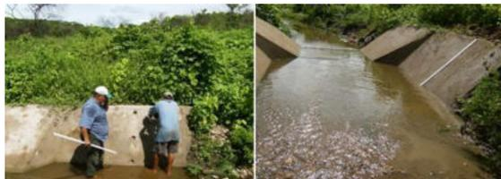
Foto 3: Instalação de régua limnimétrica em uma das calha de medição de vazão.
