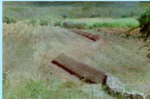
Detalhe do Canal de Retenção d'água de Um Cordão de Pedra, MBH Rio Cangati, Canindé-CE
