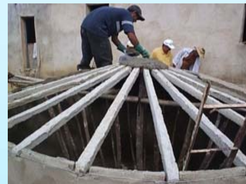
Montagem dos Trilhos da Cobertura da Cisterna
