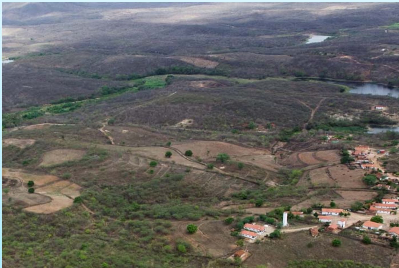
Vista Aérea da MBH do Rio Pesqueiro, Aratuba-CE.
