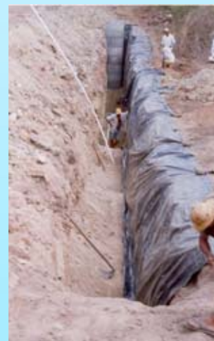
Impermeabilização e montagem da lona plástica na B.S. na MBH do Rio Pesqueiro, Aratuba-CE
