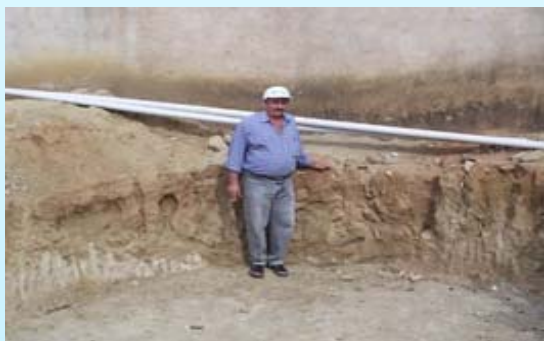
Escavação do Alicerce
