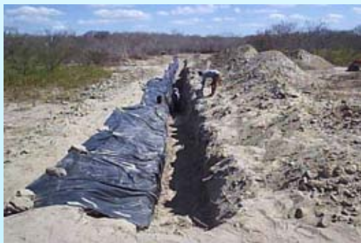
Visualização do Cut Off e a Impermeabilização com Manta Plástica na B.S.
