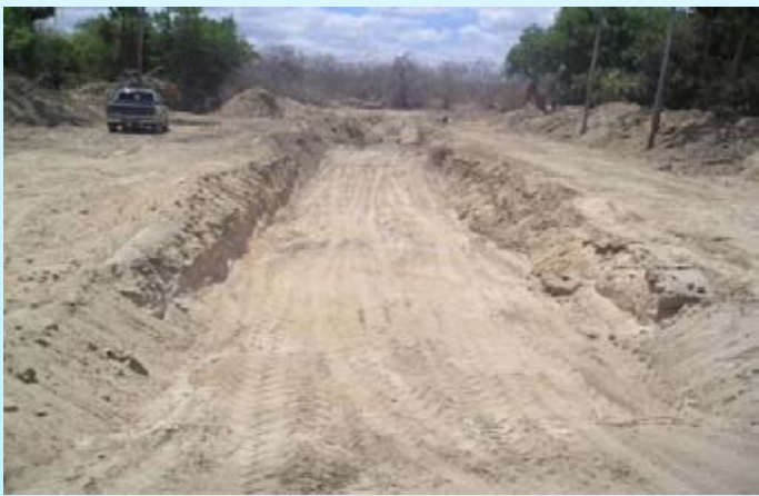
Limpeza do Eixo da B.S.
