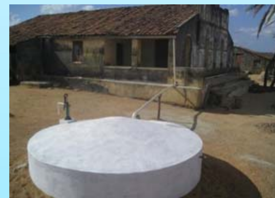
Cisterna em Funcionamento
