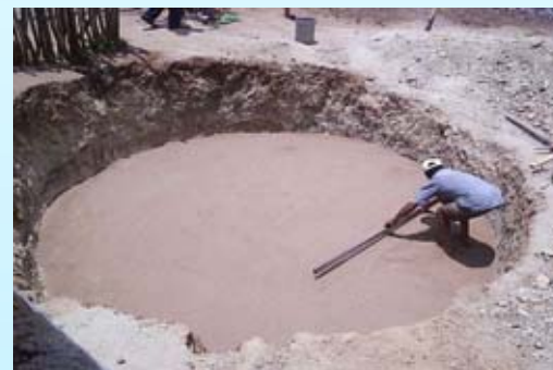
Detalhe do Acabamento do Piso da Cisterna
