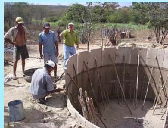
Montagem das Paredes da Cisterna
