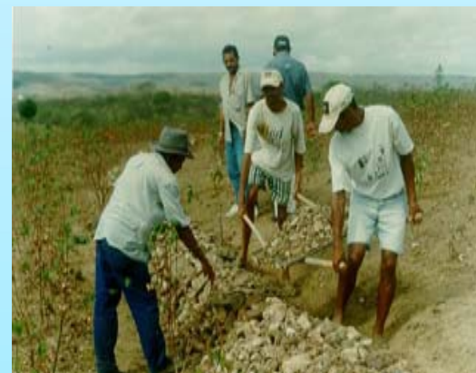
Detalhe do Transporte da Pedra em Padiola para Construção de Cordão de Pedra, MeducaBH Cangati, Canindé-CE
