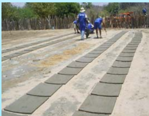
Fabricação das Placas das Paredes da Cisterna
