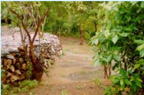
Observação da Forma de Construção da B.S.C.S. em Arco Romano. MBH do Rio Pesqueiro, Aratuba-CE
