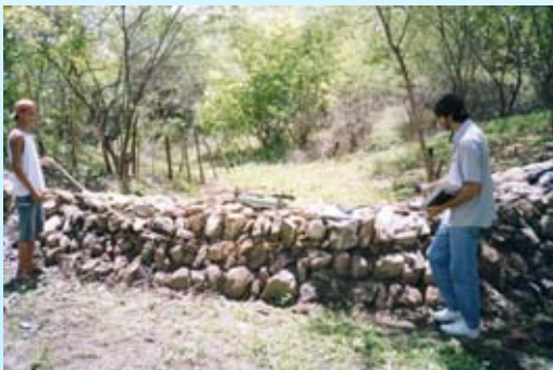
Técnicos Instalando Instrumentos de Medição em B.S.C.S.
