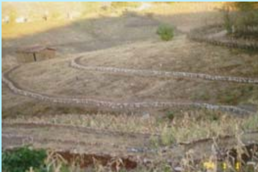
Detalhe dos Cordões de Pedra Construídos de Acordo com as Curvas e Níveis
