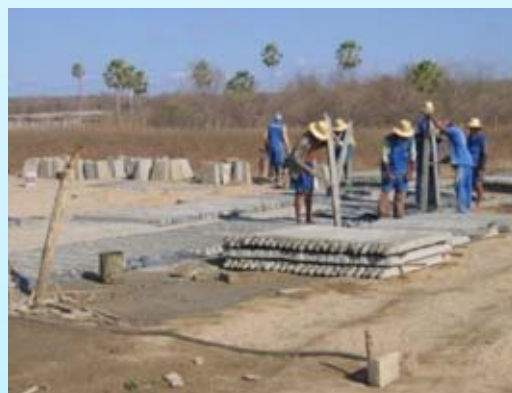
Fabricação dos trilhos da Tampa da Cisterna
