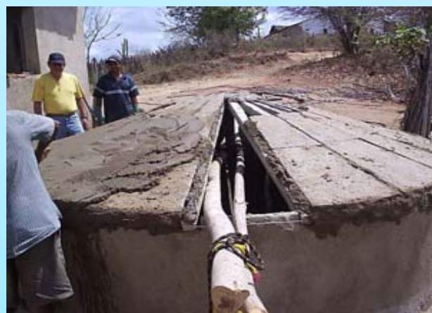
Reboco da Tampa da Cisterna
