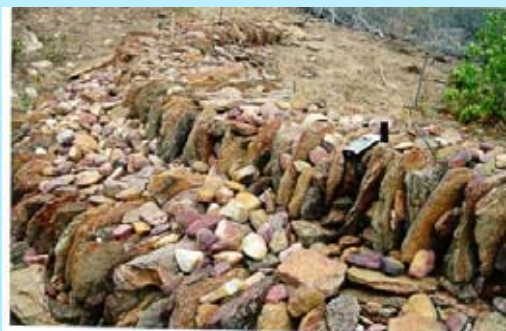
Barragem Sucessiva – Georreferenciamento com GPS
