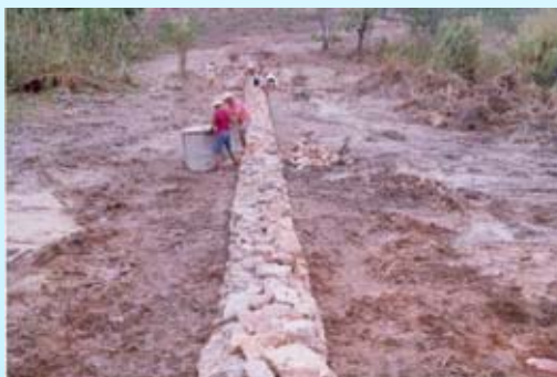
Visão do Acabamento da B.S. Observando o Poço Junto ao Enrocamento Superficial na MBH do Rio Pesqueiro
