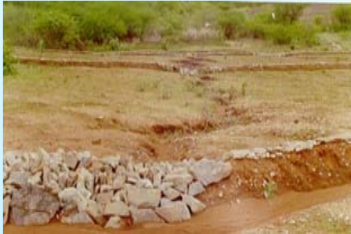
Concordância dos Cordões de Pedra com as Barragens para Contenção de Sedimentos, MBH Pesqueiro, Aratuba-CE
