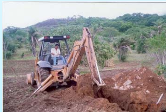
Abertura do Cut Off no Eixo B.S. na MBH do Rio Pesqueiro, Aratuba-CE
