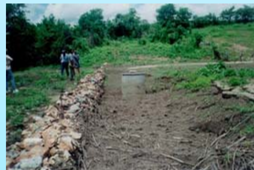
Enrocamento Superficial da B.S. com Visão das Ombreiras
