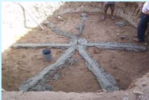
Detalhe da Preparação do Piso da Cisterna
