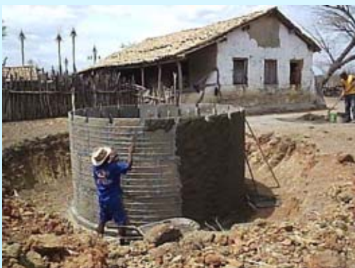
Reboco das Paredes da Cisterna
