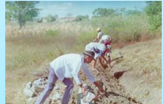
Detalhe do Uso da Mão-de-obra Local na Construção dos Cordões de Pedra, MBH do Rio Cangati, Canindé-CE
