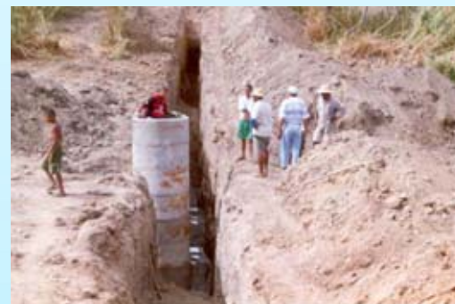
Visualização da Montagem dos Anéis para Construção do Poço da B.S. na MBH do Rio Cangati do Rio Pesqueiro em Aratuba-CE
