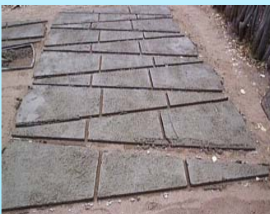
Fabricação da placas da Cobertura da Cisterna
