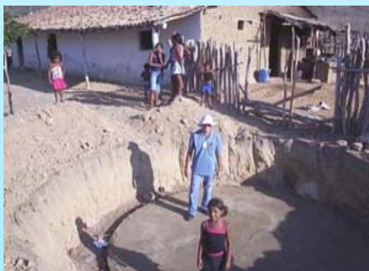
Aspecto do Piso da Cisterna
