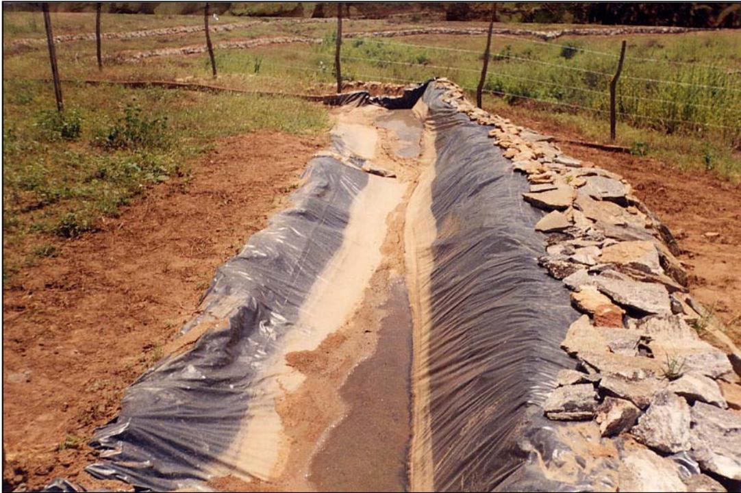
**Figura 4.14-** Coletor de sedimento da área em estudo, 2002.
