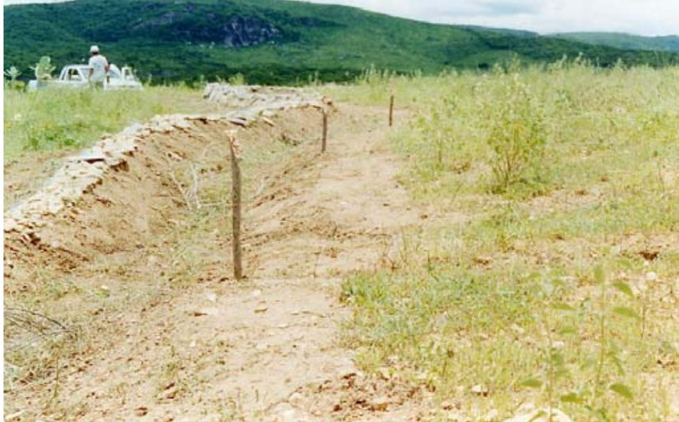
**Figura 4.7-** Construção dos cordões de pedra em contorno, 2002.
