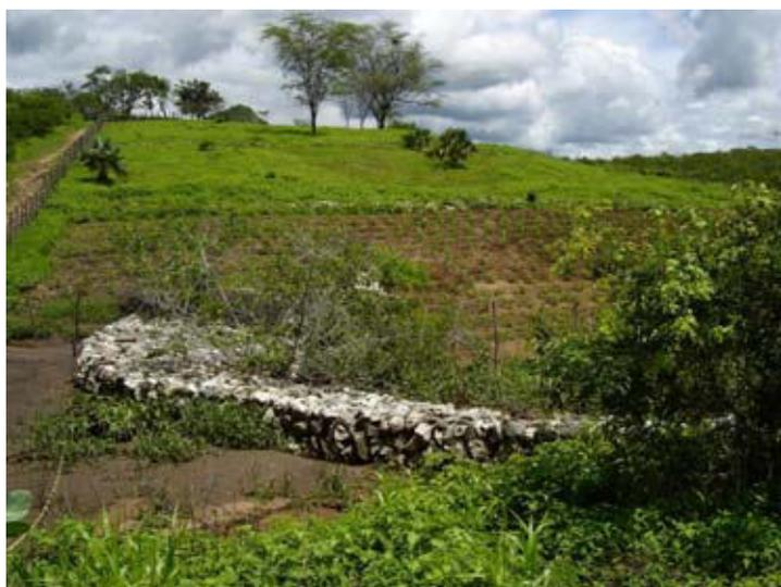
**FOTO 4.02** – Barragem sucessiva da Parcela 1 com sedimentos acumulados à esquerda.
