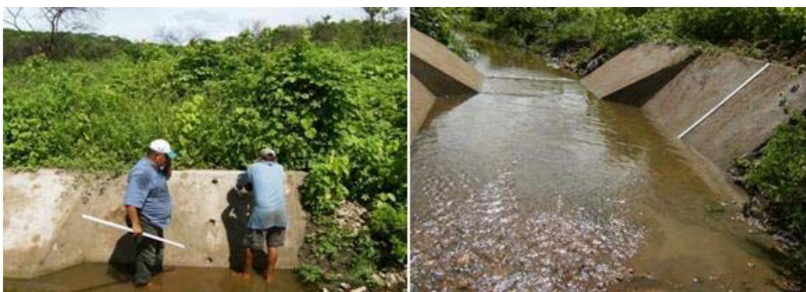
**FOTO 2.08** – Instalação de régua limnimétrica na calha 02
