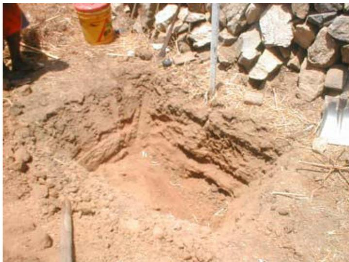
**FOTO 3.08** – Trincheira para instalação da régua na barragem sucessiva.
