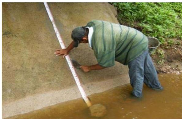
**FOTO 2.07** – Instalação de régua limnimétrica na calha 01.
