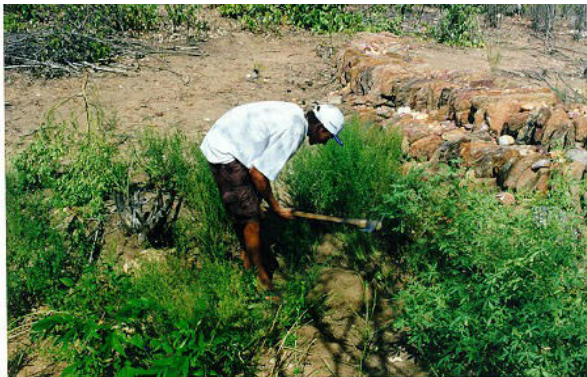
Figura 8: Perfuração do local de instalação da régua.
