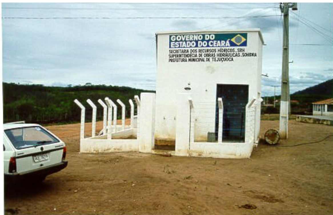
Figura 24: Estrutura de proteção do dessalinizador.
