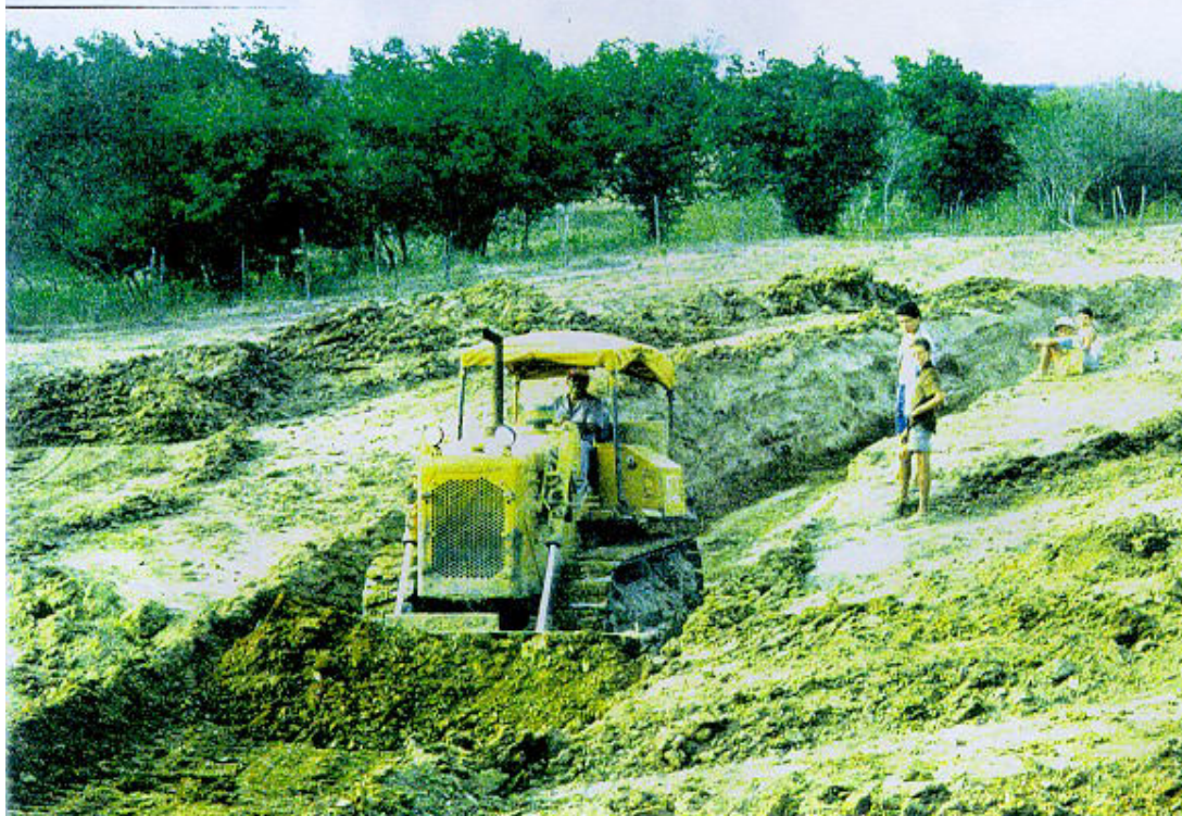
Escavação da trincheira (vala) com trator, transversalmente ao curso do riacho
