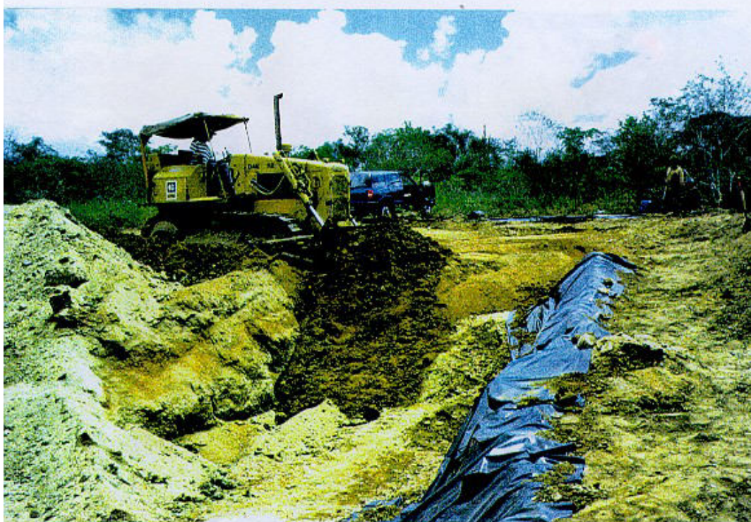
Completada a impermeabilização da parede de jusante, é iniciado o preenchimento da trincheira com o próprio material dela retirado
