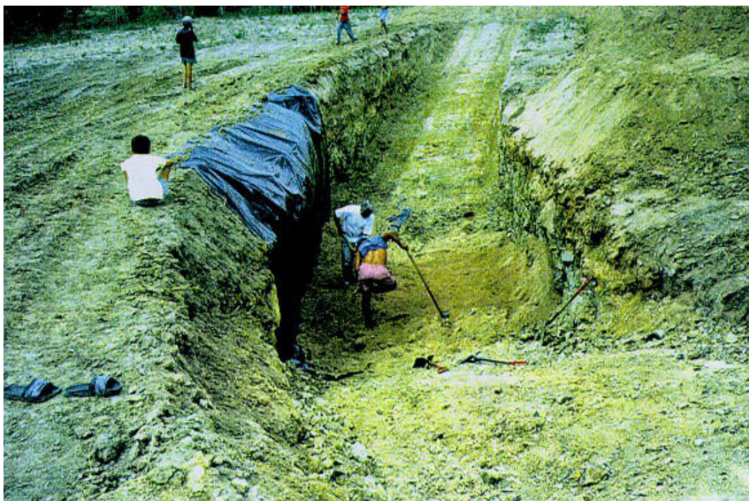
Iniciada a impermeabilização com lona plástica da parede de jusante da trincheira. No inverno as águas do riacho correm da direita para a esquerda (na foto)
