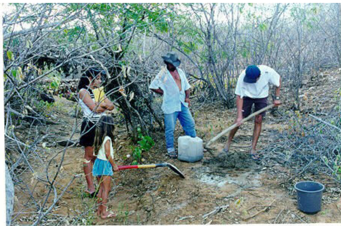
Figura 9: Preparação do concreto para fixação da régua.
