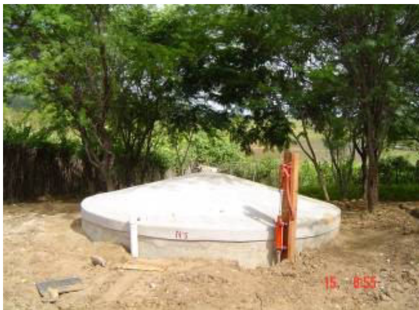
Figura 4.4. Cisterna de placa construída pelo projeto
