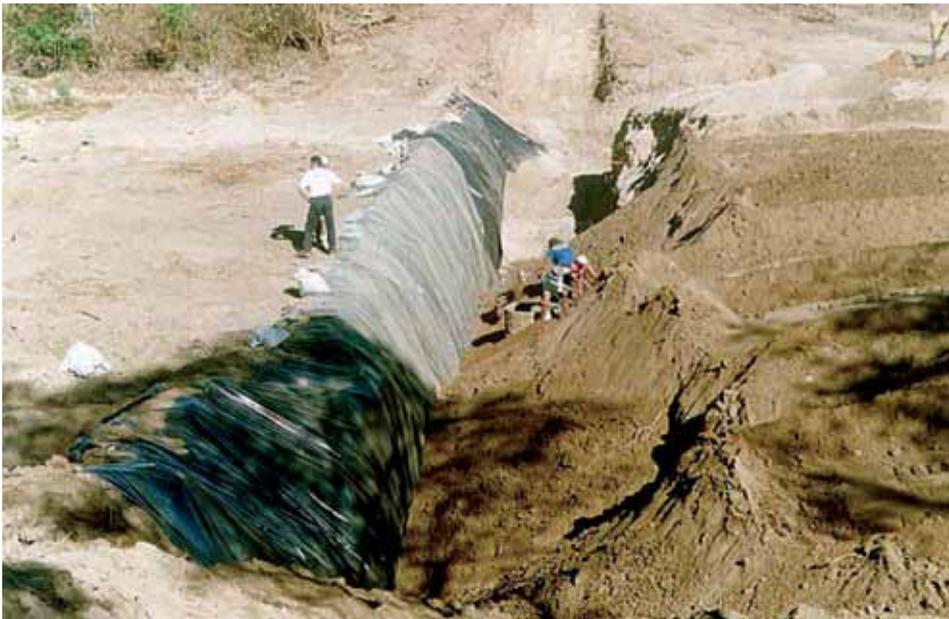
**Foto 10 – Disposição da Lona de uma Barragem Subterrânea**
