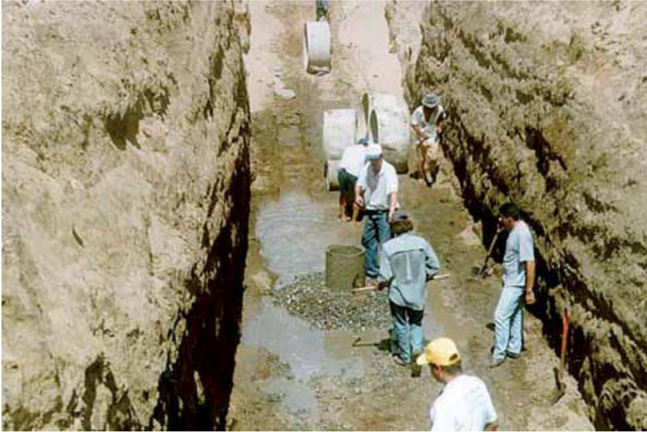
**Foto 9 –Aspecto da Vala de uma Barragem Subterrânea Vendo-se, ao Centro, a Fundação do Poço Amazonas**
