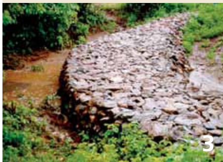
Figura 3. Detalhamento do efeito do barramento após as primeiras chuvas, observando a retenção do "húmus" compactando os interstícios da estrutura do barramento; Foto: Equipe técnica do PRODHAM
