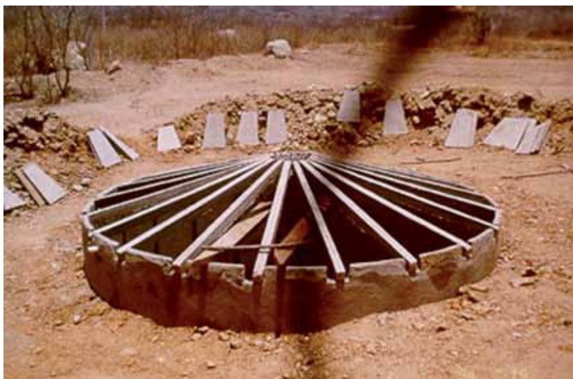
Foto 10 – Montagem dos Trilhos
