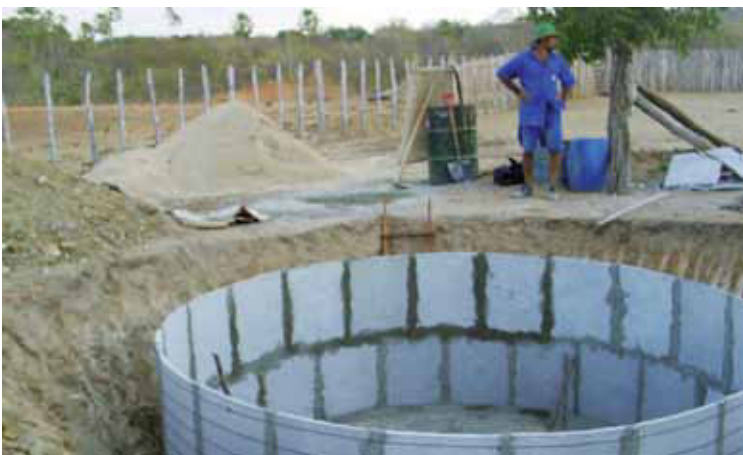
Foto 8 – Vista do Piso e Montagem das Placas
