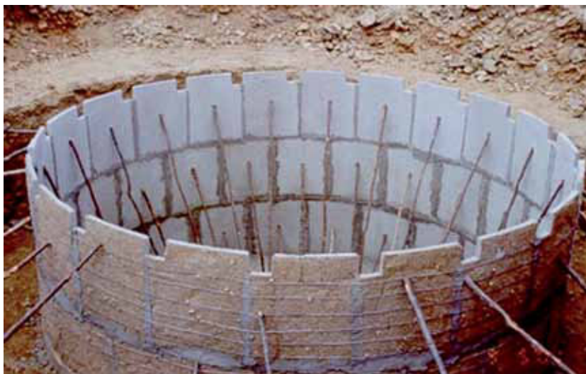
Foto 9 – Montagem das Placas
