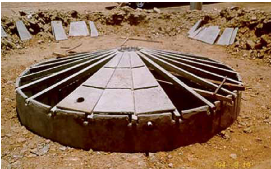
Foto 11 – Montagem da Tapa
