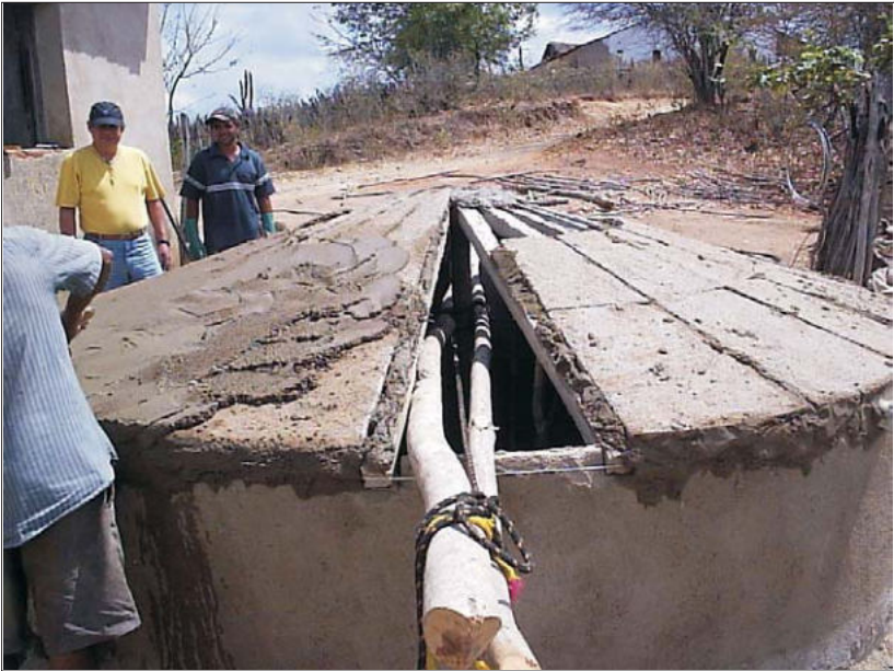
Foto 7 – Detalhes da Montagem da Tampa da Cisterna
