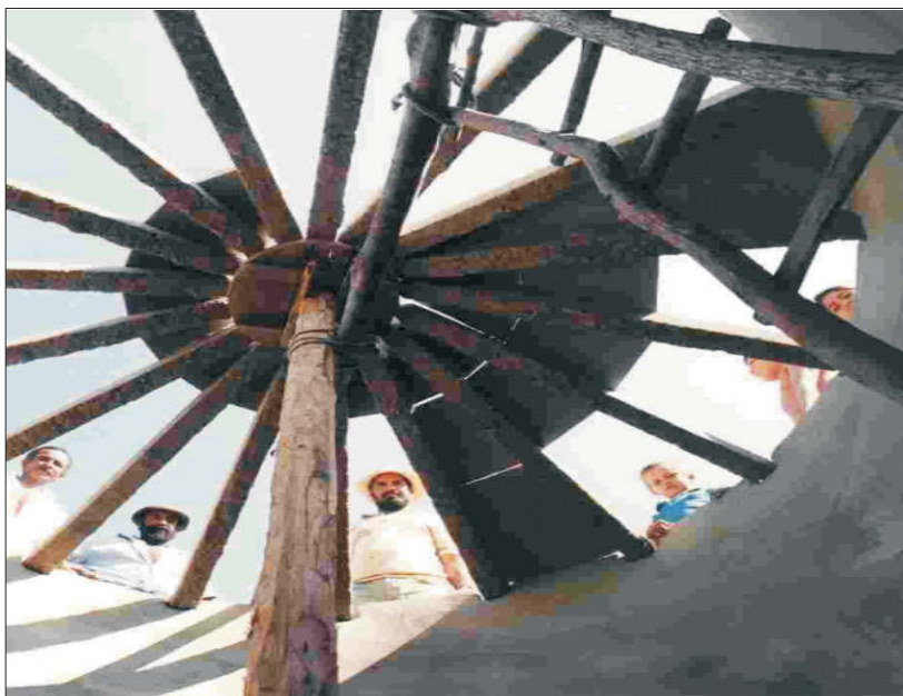
Foto 6 – Detalhes da Estrutura da Tampa da Cisterna
