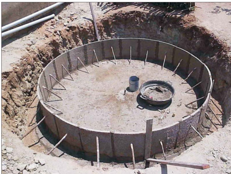
Foto 4 – Montagem da 1ª. Fileira de Placas
