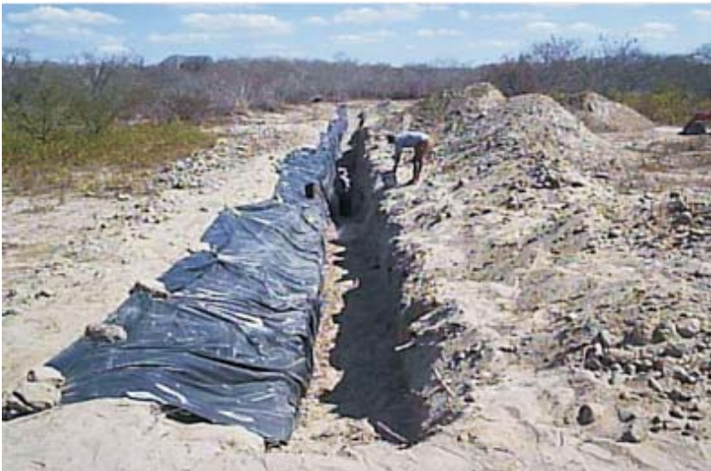
Foto 4 – Colocação da Lona
