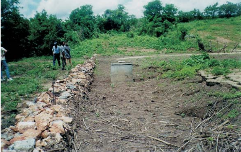
Foto 7 – Aspecto Externo de uma Barragem Subterrânea
