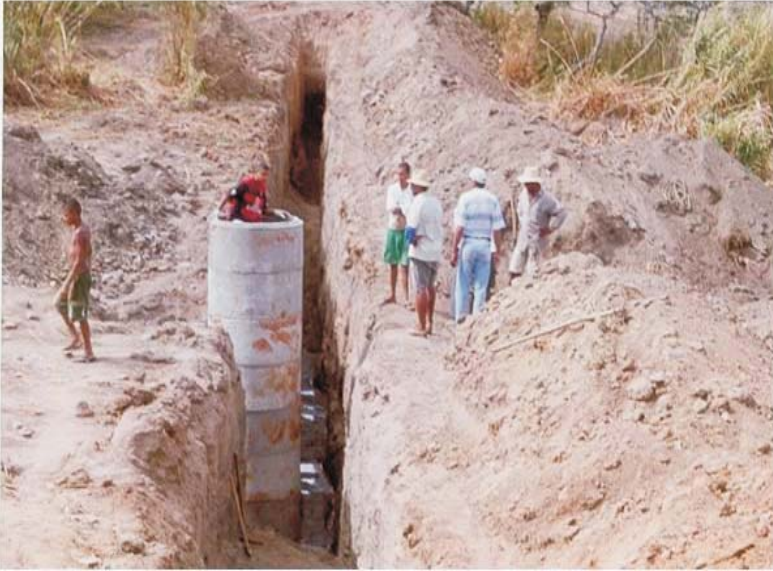
Foto 3 – Vala Escavada e Poço Amazonas
