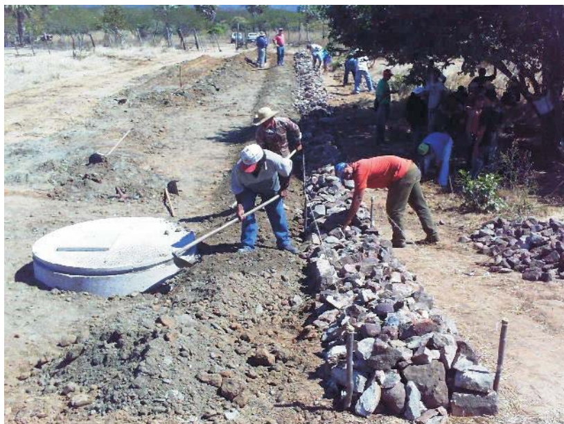
Foto 6 – Enrocamento de Pedras
