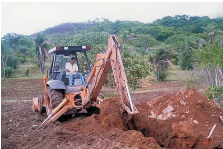
Foto 2 – Escavação da Vala
