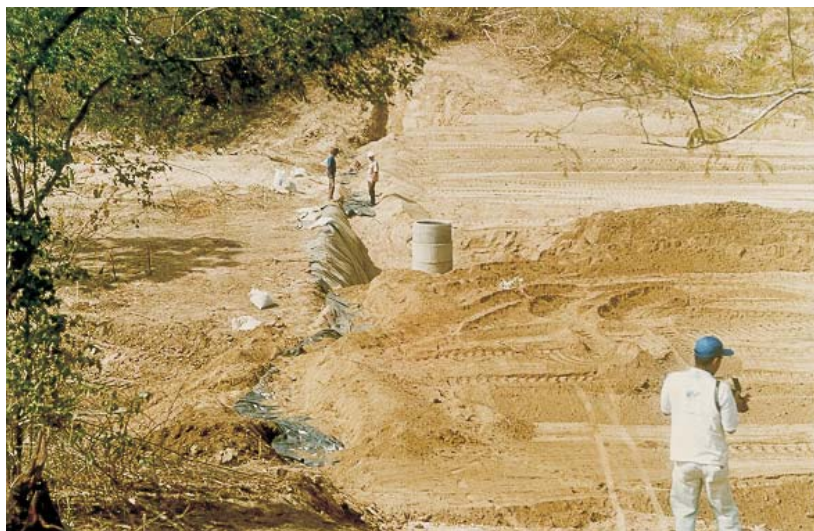
Foto 5 – Reaterro a Vala
