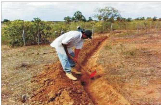
Foto 5 – Cordão – Abertura do Canal
