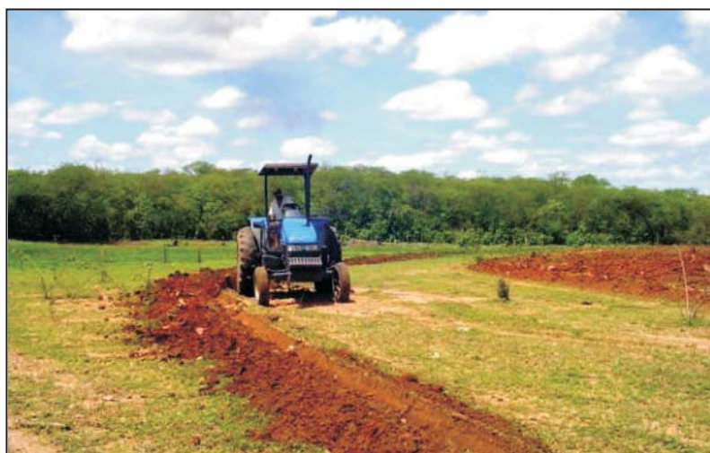
Foto 1 – Construção Terraços Iracema-CE
