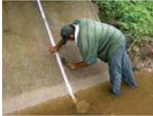
FOTO 2.07 – Instalação de régua limnimétrica na calha 01
