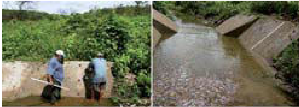
FOTO 2.08 – Instalação de régua limnimétrica na calha 02
