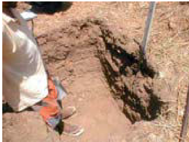
FOTO 3.10 – Abertura da trincheira.
