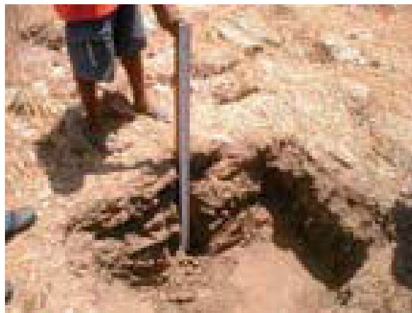
FOTO 3.09 – Instalação da régua.
