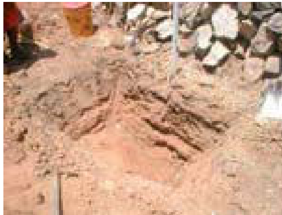
FOTO 3.08 – Trincheira para instalação da régua na barragem sucessiva.
