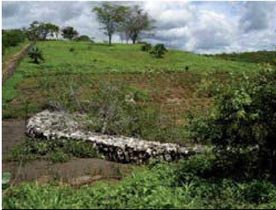
FOTO 4.02 – Barragem Sucessiva da Parcela 1 com sedimentos acumulados à esquerda.
