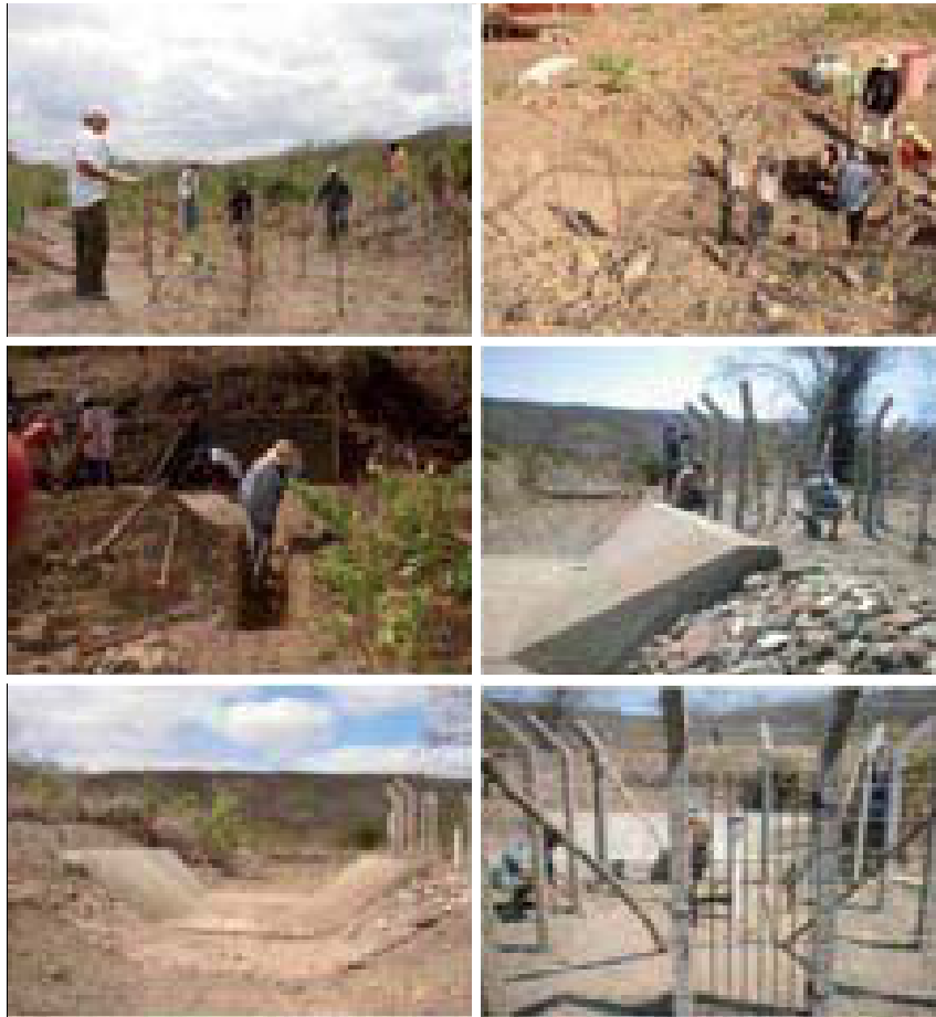
FOTO 2.04 – Fases construtivas da calha 02: marcação, ferragem, concretagem, acabamento e finalização.
